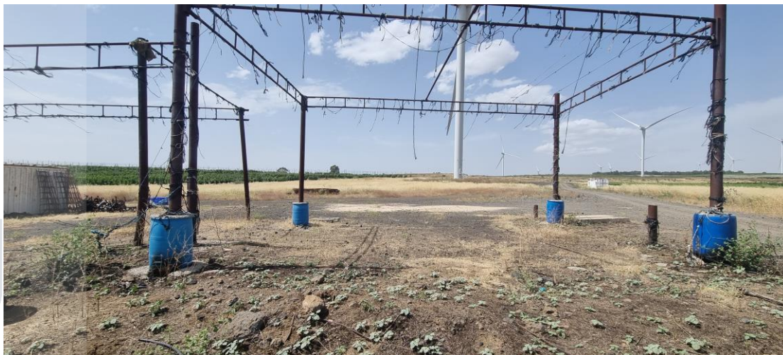
איור 56. סככה חקלאית – מבט צפונה
